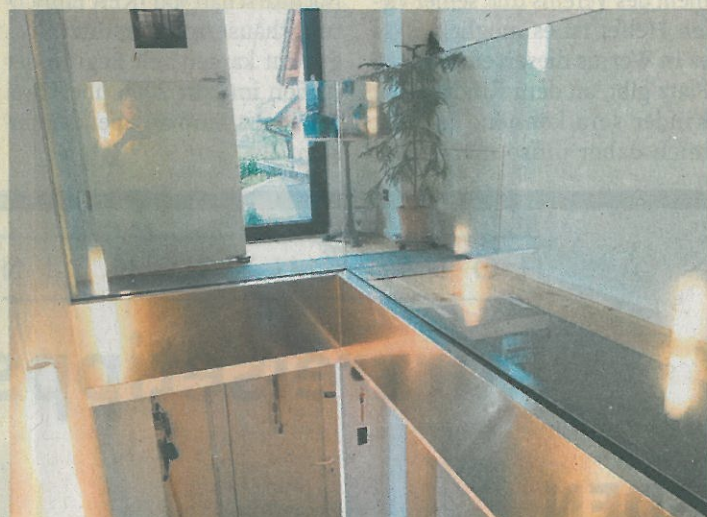
Geländer aus Ganzglas erhalten das Licht und den Eindruck großzügiger Raumeinteilung auch in kleinen Gebäuden.
