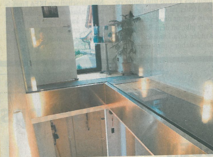
Geländer aus Ganzglas erhalten das Licht und den Eindruck großzügiger Raumeinteilung auch in kleinen Gebäuden.
